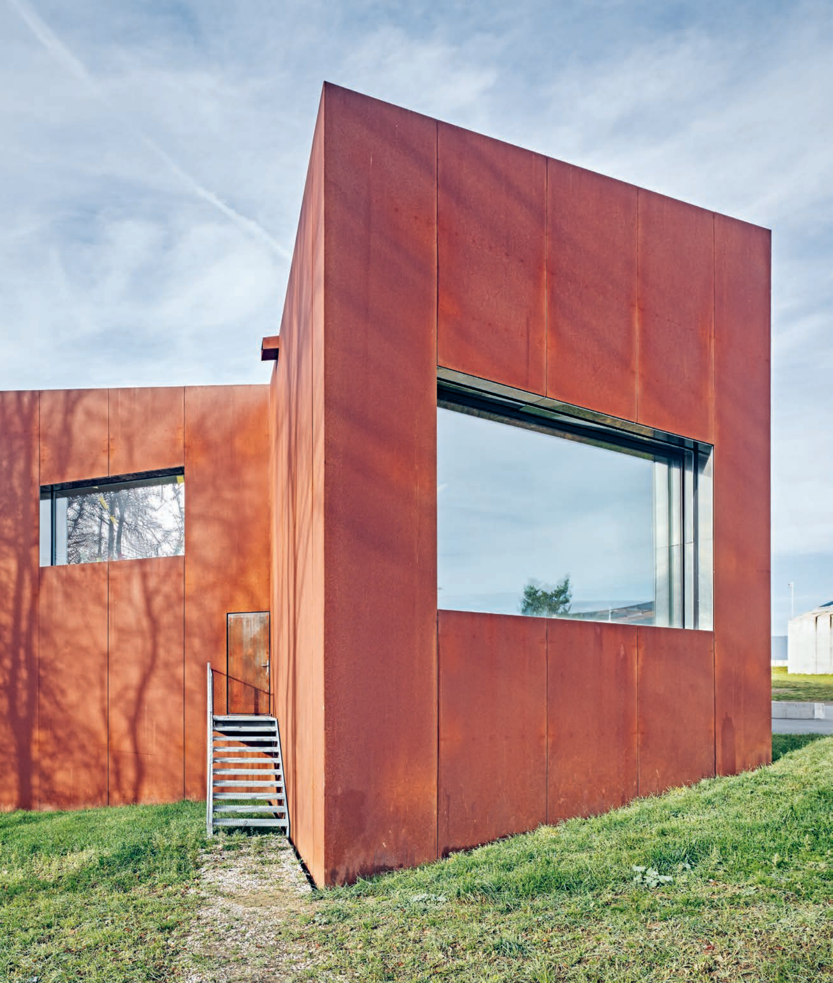
Schräge Schnitte und grosse Öffnungen an der Stirnseite des Gebäudes geben der Cinémathèque suisse eine klare Adresse und ein markantes Gesicht.
